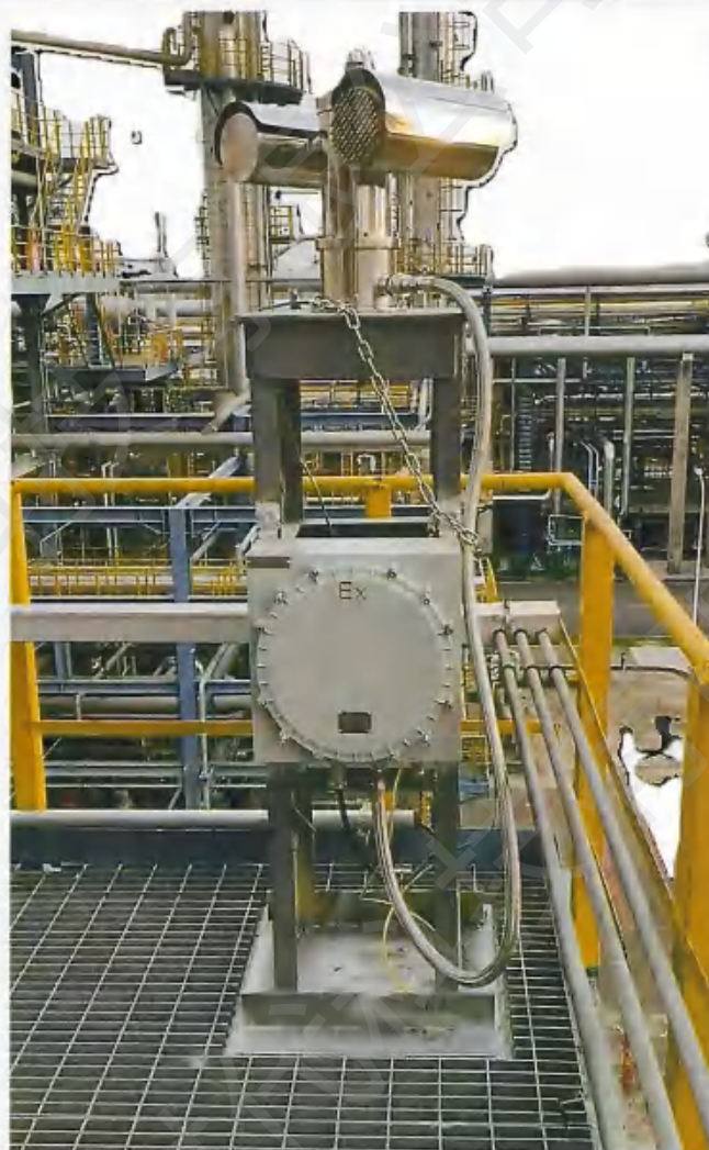
图 7 现场实际安装图
